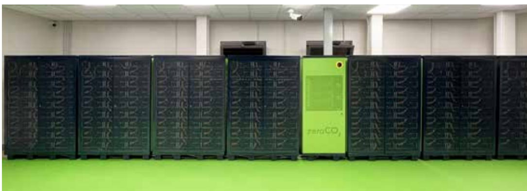
IMPIANTO ZEROCO2 XL INSTALLATO DA 490KWP DI POTENZA E 1,1 MWH DI CAPACITÀ DI ACCUMULO
