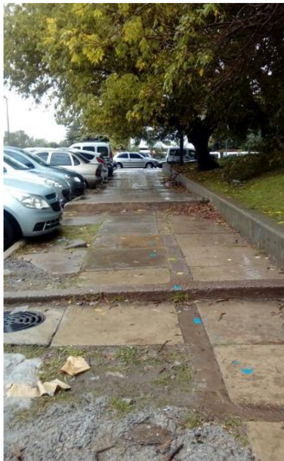
Ingresos laterales, se observa un escalonamiento innecesario, pudiendo habilitar un acceso rampante con pasamos así se cuida la seguridad del peaton y usuario en silla.
