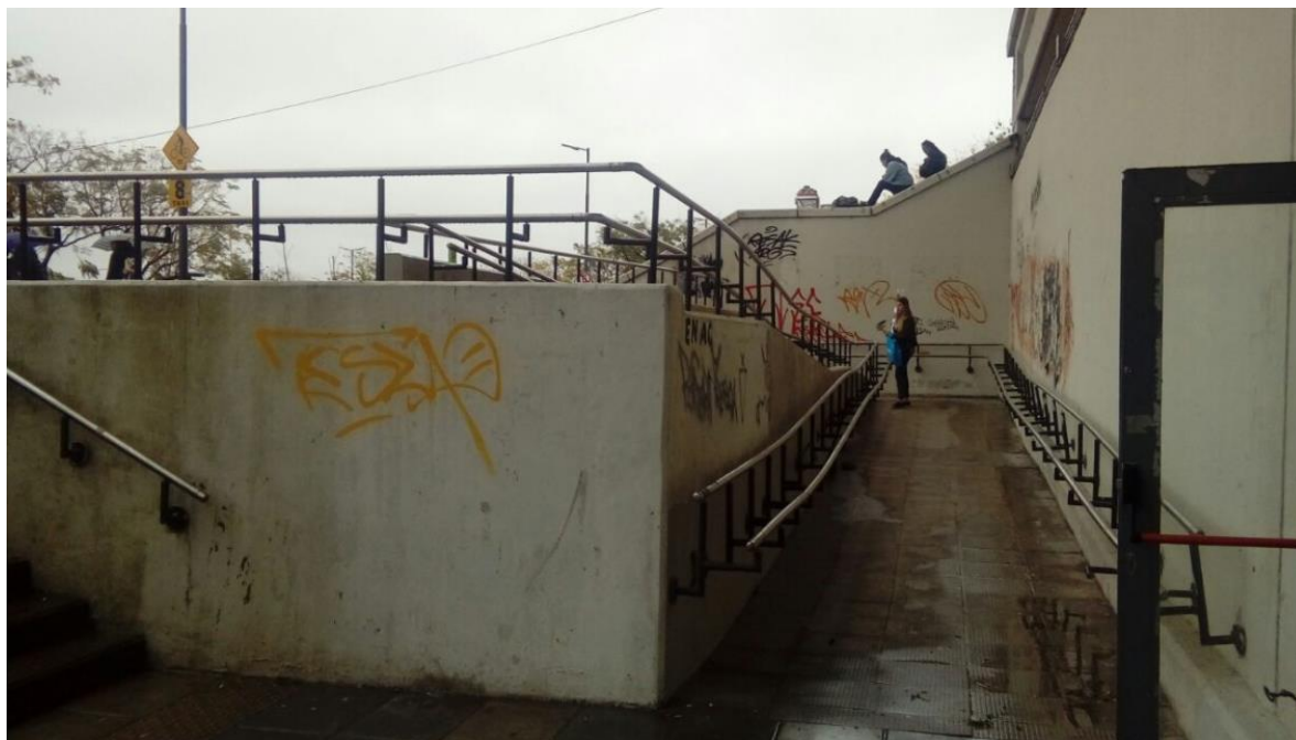
Rampa de acceso frente las dársenas de colectivos e ingreso.
