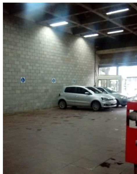
Segundo acceso lateral por el cual ingresan los vehículos y esta a nivel en subsuelo, pudiendo ingresar en silla de ruedas. Hay espacio reservado para autos conducidos por personas con movilidad reducida.
