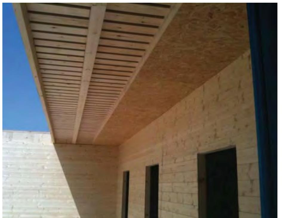
Bastidor de cubierta montado en obra
