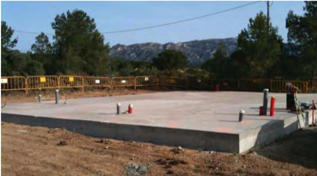
Basamento húmedo, con las instalaciones sanitarias de desagües ya instaladas.
