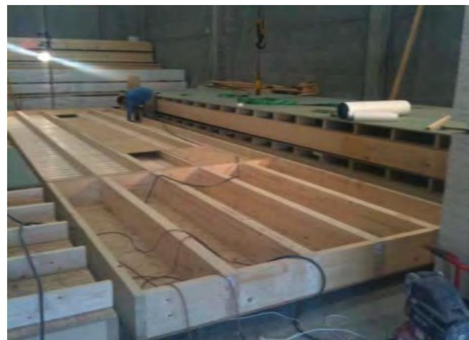
Bastidor para cubierta
